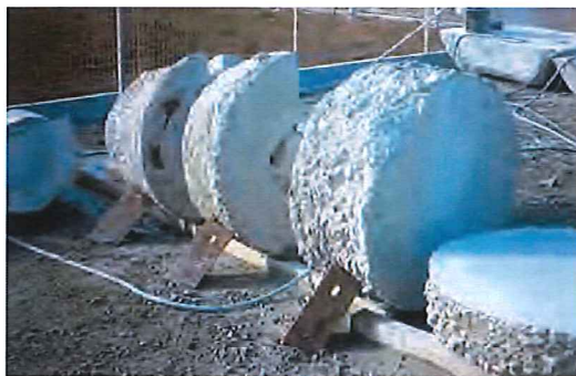
切断状況(全体)
