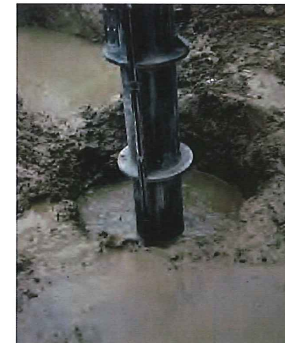
①掘削孔に装置挿入
