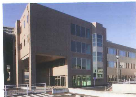
支援業務事例(千葉県国保会館増築工事)
