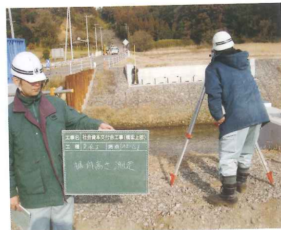
橋梁下部工事施工管理事例
