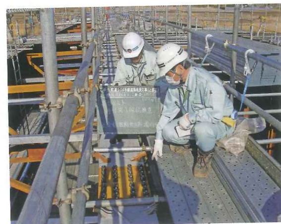
橋梁上部工事施工管理事例
