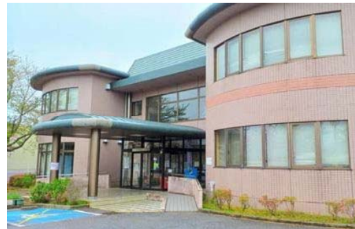
令和9年度に工事予定の桜台センター
