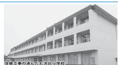
改修工事の済んだ七次台小学校
