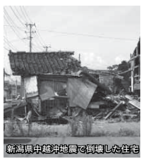
新潟県中越沖地震で倒壊した住宅
