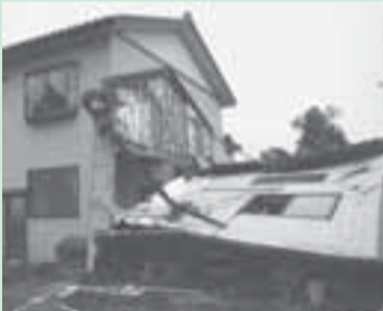
新潟県中越沖地震で倒壊した住宅
