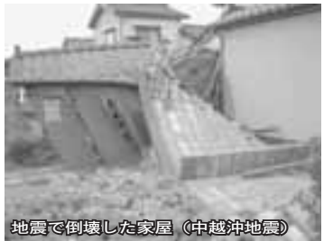
地震で倒壊した家屋（中越沖地震）
