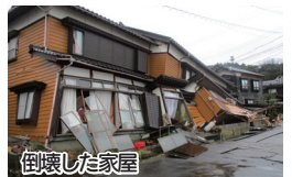
倒壊した家屋
