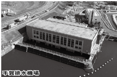
手賀排水機場
