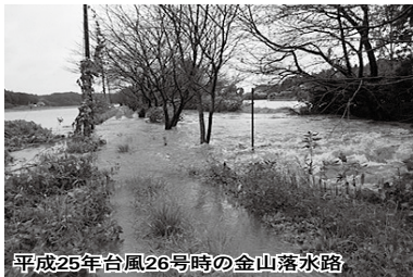
平成25年台風26号時の金山落水路
