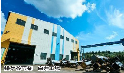
鎌ヶ谷巧業 白井工場
