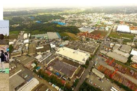
千葉県内最大規模の 内陸工業団地「白井工業団地」
