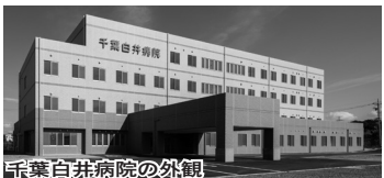
千葉白井病院の外観
