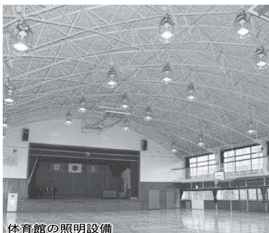
体育館の照明設備
