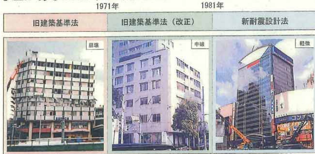
中間層崩壊の事務所ビル 雑壁せん断破壊の事務所ビル 被害のほとんどない事務所ビル
