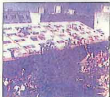
新潟地震(1964) [液状化現象による倒壊]
