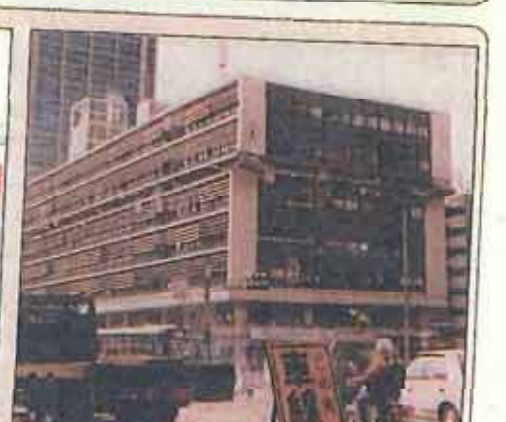
柱破壊による中間階の崩壊
