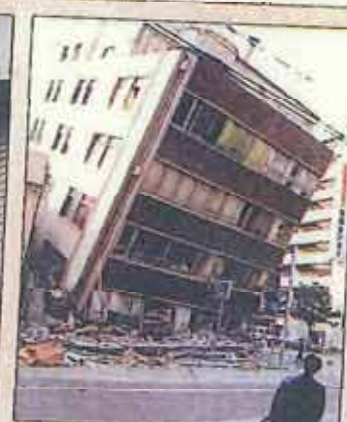
柱壁破壊による1階の崩壊
