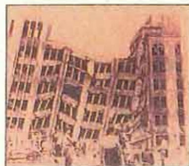
福井地震(1948) [柱・壁が少ない建物の崩壊]
