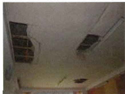
水周りの腐朽、仕上げの劣化、剥落、雨漏りなどの老朽化が進んでいた。
