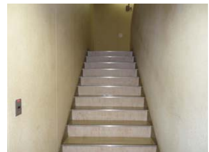
手摺が未整備でバリアフリーに対応できていない階段
