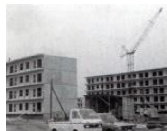
ニュータウンの建設（昭和 54 年頃）
