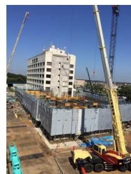
市役所庁舎整備（平成 28 年）
