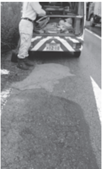
穴埋め補修された道路
