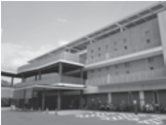
市役所右奥にある保健福祉センター
