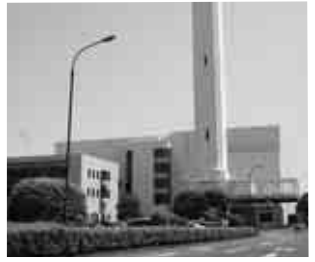
印西クリーンセンター
