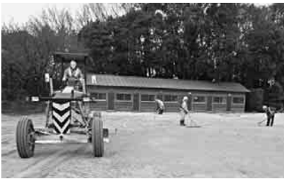
除染作業をすすめています
