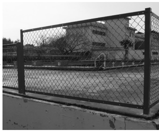
改修を終えたブロック塀
