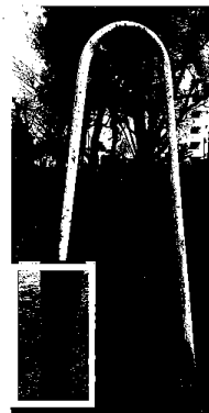
上左 ニュータウン開設時、40年経過の白看板。脚のサビ、看板はずれも。下 市政開始時、20年経過の茶色看板。
