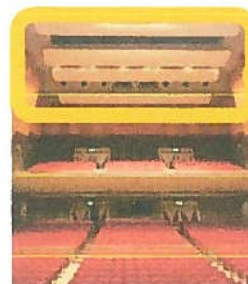
大ホールの天井
