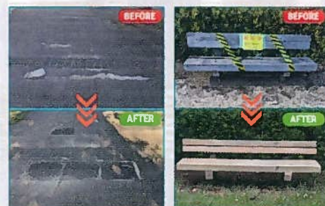
コンクリート損傷修理 桜台：十倉一公園からの遊歩道
