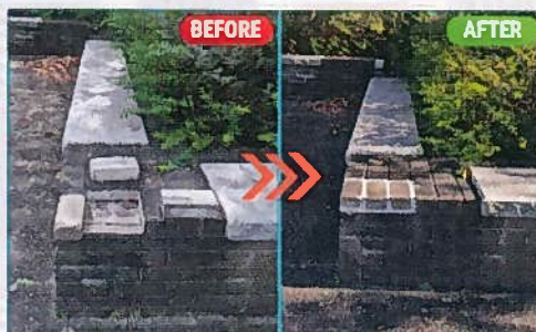
レンガ損傷修理 桜台：十倉一公園からの遊歩道
