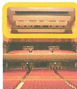
大ホールの天井
