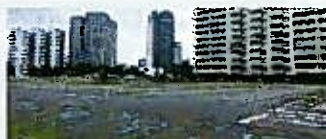
データセンター建設予定地
