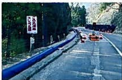
輪島市の仮設水道管
