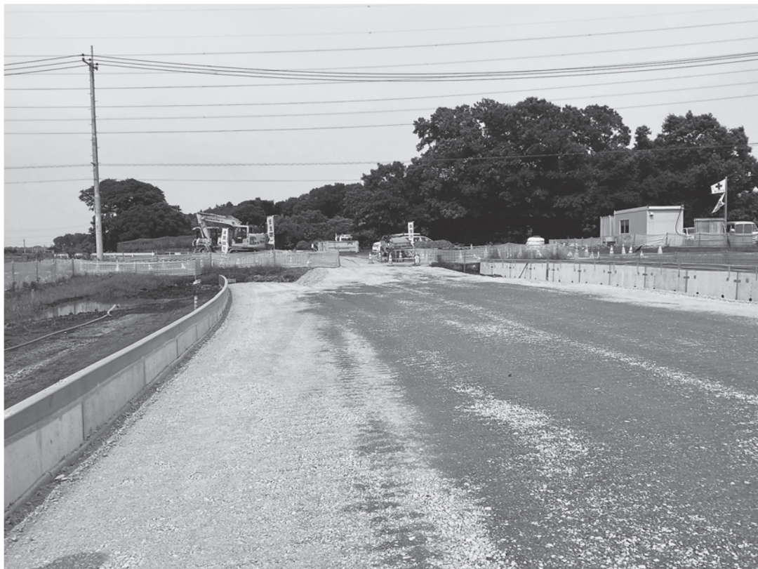
建設中の工業団地アクセス道路(P.8-①)富塚地先
