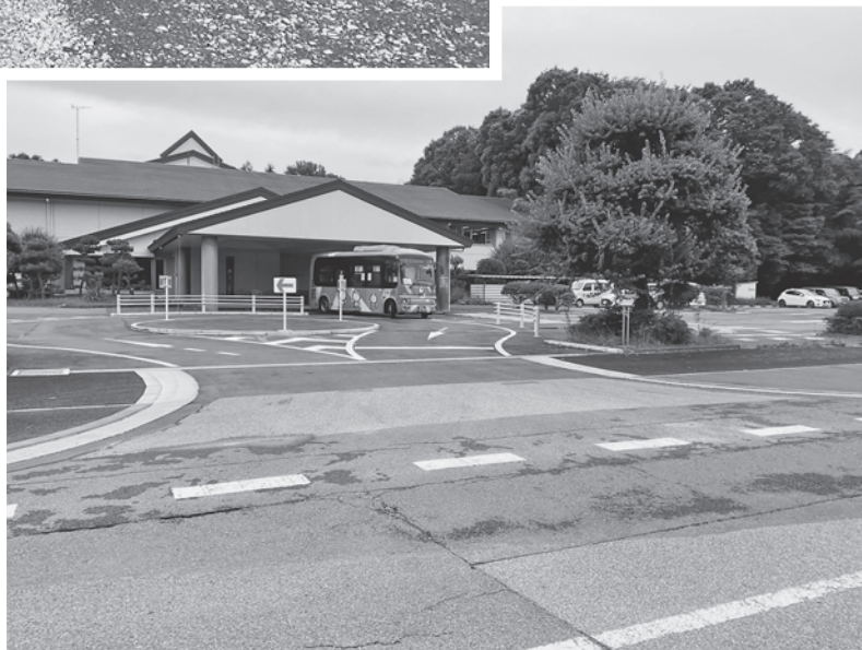
千葉NT北環状線に係る市道整備状況(P.8-⑤) 福祉センター内に作られた回転路
