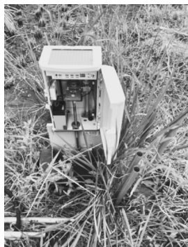
②水門開閉で水量を遠方でコントロール
