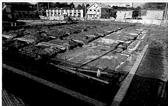
建設中の西白井コミュニティセンター
