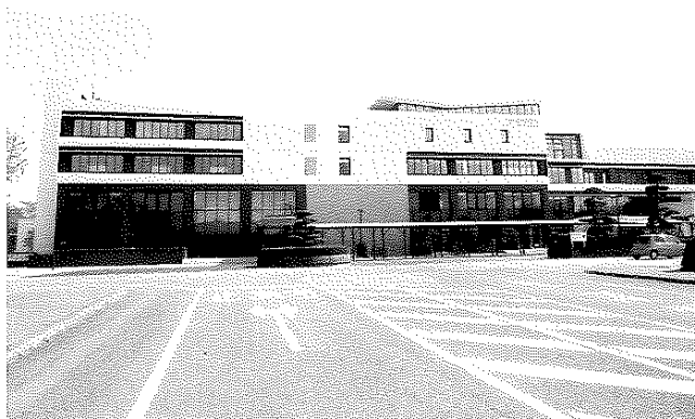
完成した白井市東庁舎、印西警察署分庁舎も入居
