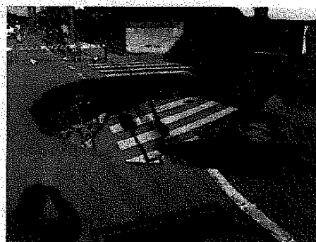
震災当時、習志野市での液状化現象の様子
