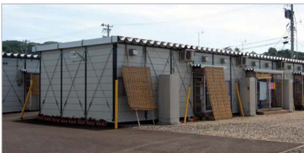
応急住宅の様子（平成19年能登半島地震、輪島市）
