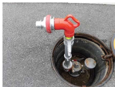
【媒介金具の設置状況】
