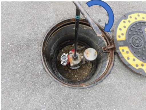
【スピンドルドライバー取り付け】
