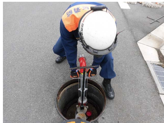
【スタンドパイプ取付け】
