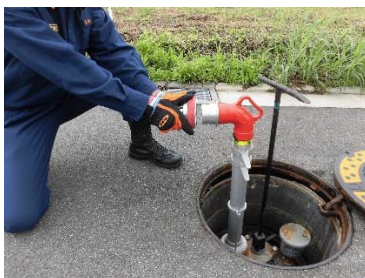
【媒介金具の取り付け】
