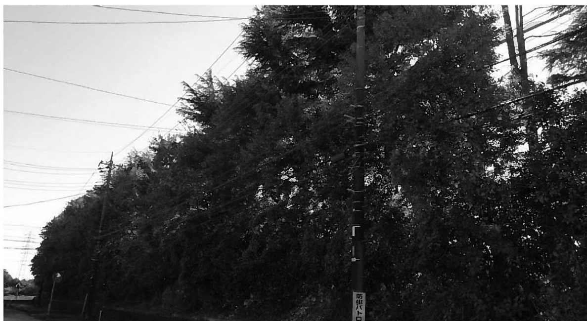
↑(敷地外道路側から撮影) ヒマラヤスギ直下の樹木が歩道側へも成長し、電線・電話線への接触も見られます。
