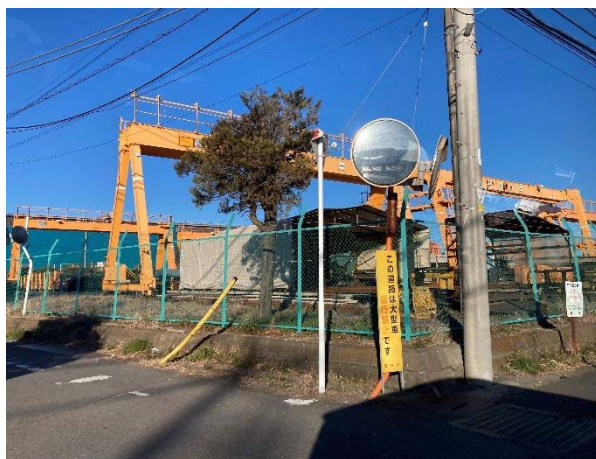
写真 8 白井工業団地
