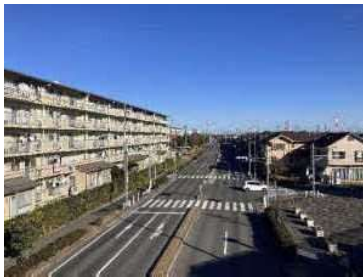
中層の団地と戸建て住宅 (堀込地区・池の上地区)
