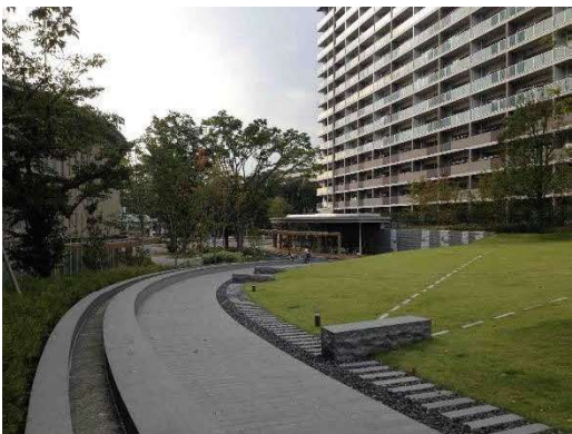
低層階と高層階へと外壁色にグラデーションを付けて、周囲への圧迫感を軽減している
