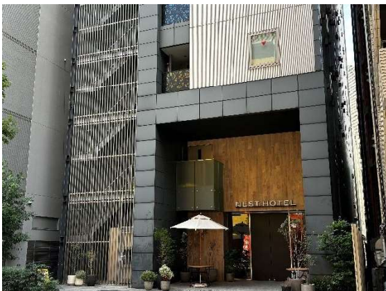
屋外階段を建築物外壁と調和した色彩のルーバーで囲うことで、通りから目立たない
