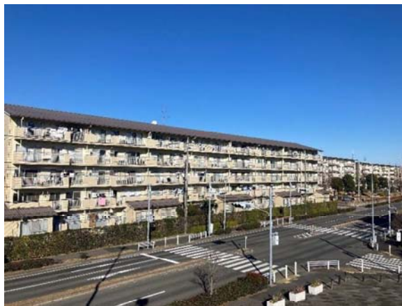
写真 堀込の団地
