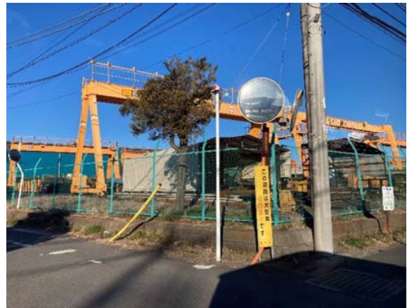
写真 白井工業団地
