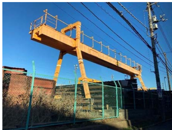
写真 クレーン
