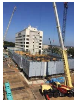
市役所庁舎整備（平成 28 年）
