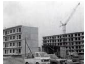
ニュータウンの建設（昭和54年頃）
