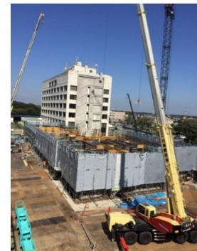
市役所庁舎整備（平成28年）
