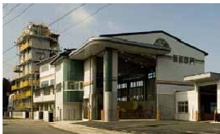
図2-5-6 バイオマスガス化発電施設
