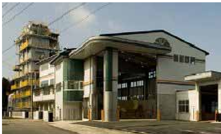
図2-5-6 バイオマスガス化発電施設
