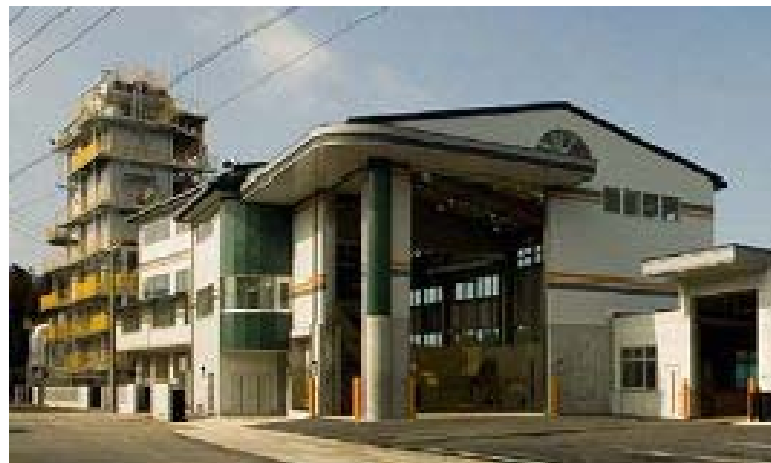
図2-5-6 バイオマスガス化発電施設
