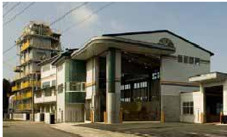
図2-5-6 バイオマスガス化発電施設
