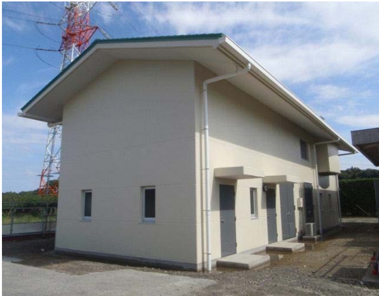
七次中継ポンプ場（外観）
