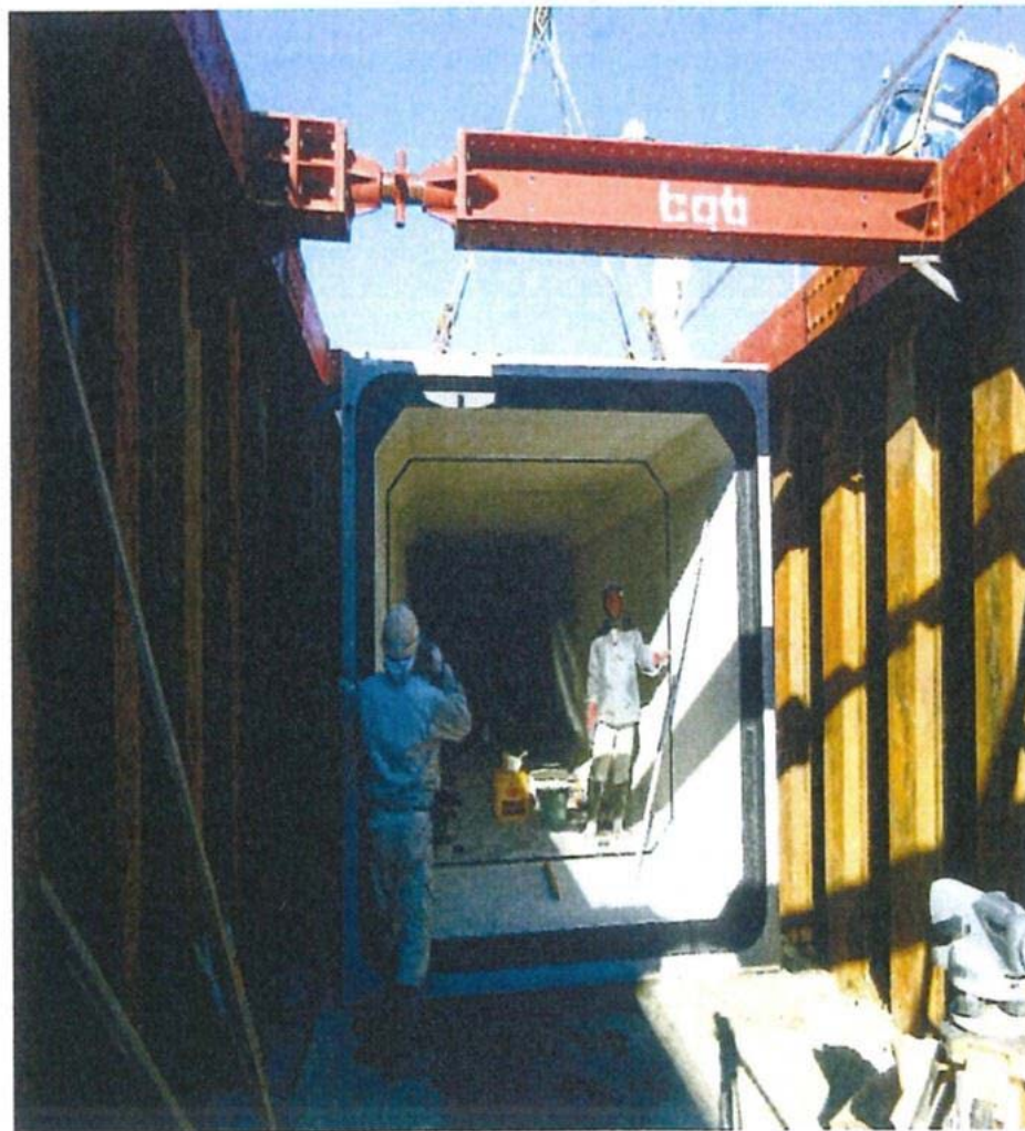
神崎20号雨水幹線 工事写真
