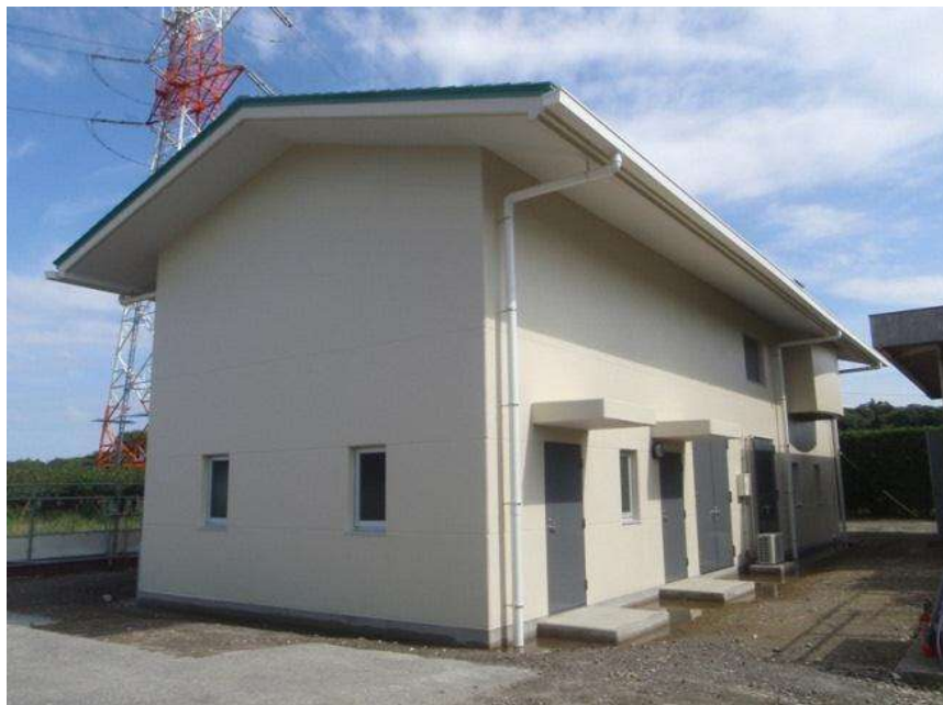
七次中継ポンプ場（外観）
