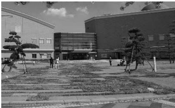
文化センター外観（改修前）
