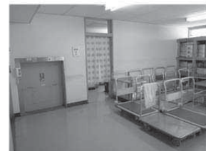
*2 エレベーター
