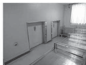
*2 エレベーター
