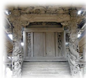
富塚鳥見神社本殿の庇柱
