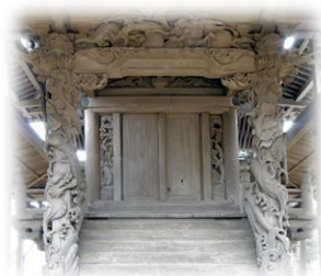
富塚鳥見神社本殿の庇柱
